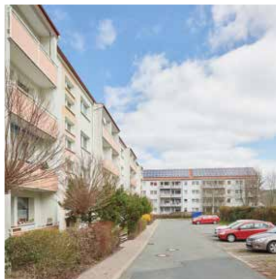
Wohngebiet „Karl-Marx-Straße“ mit PV
