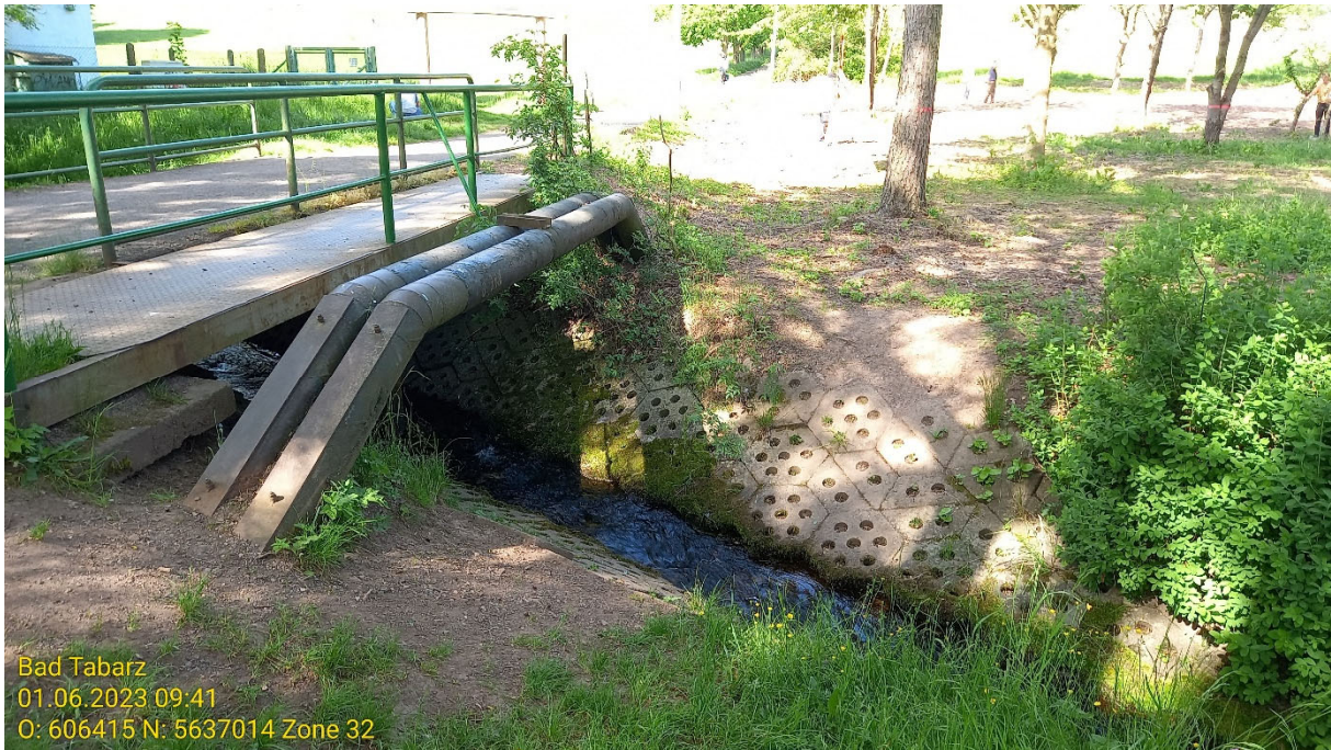
Bild 3 Fußgängerbrücke Postweg südliche Bearbeitungsgrenze
